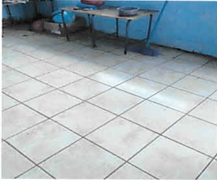
Foto 1: Piso de la EORM
