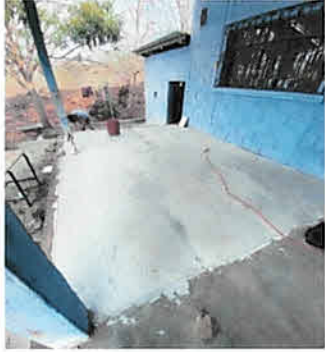
Foto 1: Sustitución y fundición de torta de concreto para colocar piso cerámico antideslizante
