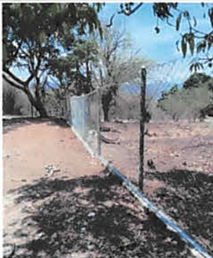
Foto 3: Reposición de malla de muro perimetral
