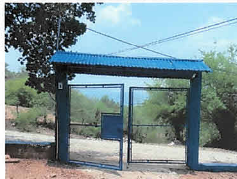
Foto 4: Mantenimiento de portón existente (chapa y pintura)
