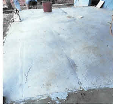
Foto 2: Sustitución y fundición de torta de concreto para colocar piso cerámico antideslizante
