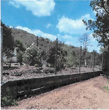
Foto 1: Reposición de malla de muro perimetral
