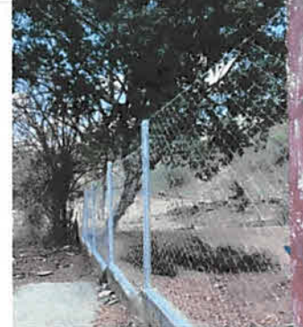
Foto 2: Reposición de malla de muro perimetral
