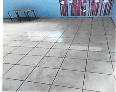
Foto 2: Piso de la EORM
